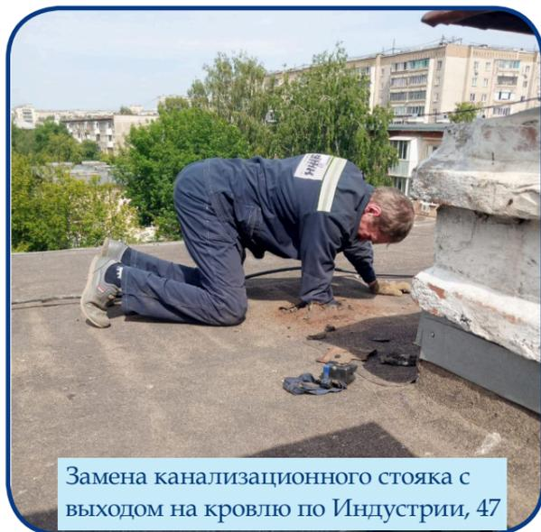
Замена канализационного стояка с выходом на кровлю по Индустрии, 47
