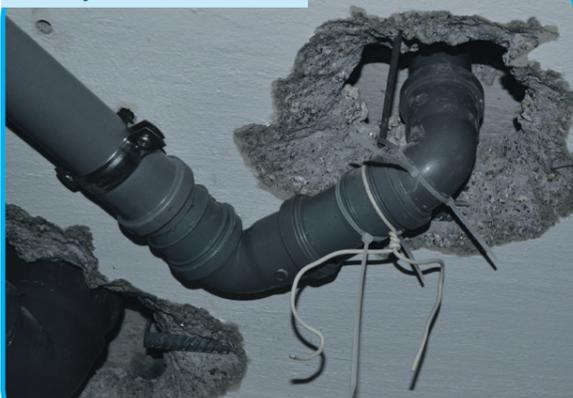
Пробиты перекрытия и железный каркас внутри бетона. Как долго они выдержат тяжесть четырех этажей - вопрос времени.
